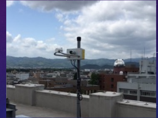
図1 理学部1号館屋上設置のレーザ式降水粒径速度分布測定装置
