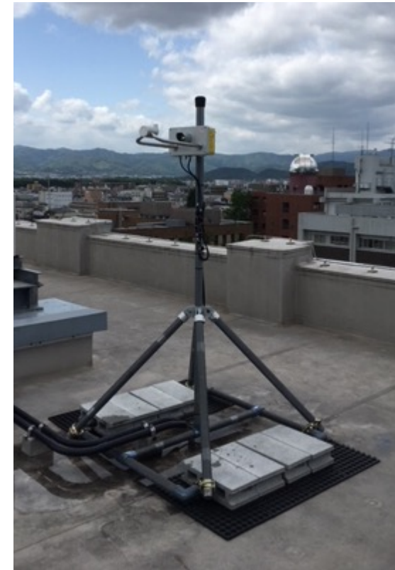
図 理学部1号館屋上設置のレーザ式降水粒径速度分布測定装置
