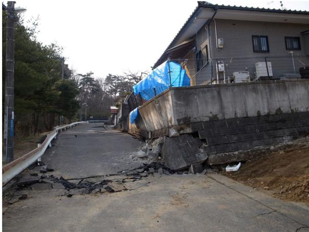
写真-1 2011年東北地方太平洋沖地震による谷埋め盛土末端の宅地崩壊（仙台市青葉区）
