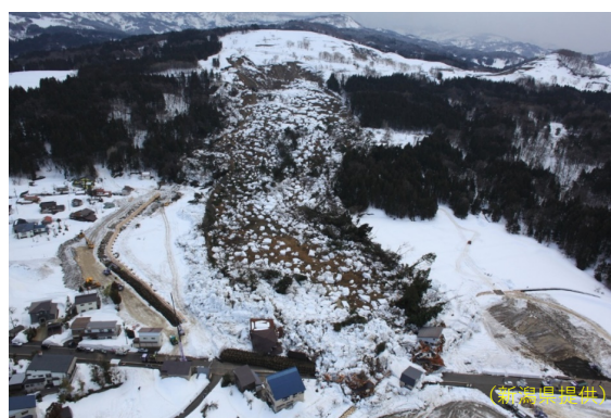
図1 融雪期に発生した地すべり (新潟県上越市板倉区国川地区)
